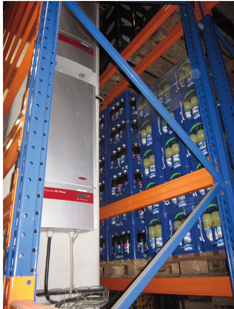
Abb. 10.5.4.1-1: PV-Wechselrichter in einem Lager für PET-Flaschen in Kunststoffkisten, Quelle: VGH Versicherungen
