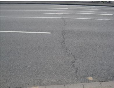
Abb. 7.5.2-2 Querrisse im Bereich der Fahrbahn (Quelle: Rupp)
