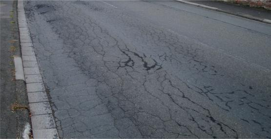
Abb. 7.5.2-1 Netzrisse im Bereich der Fahrbahn (Quelle: Rupp)
