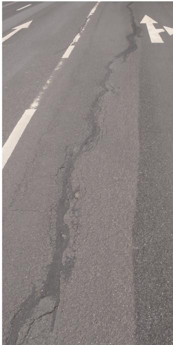
Abb. 7.5.2-3 Längsrisse (teilweise vergossen) im Bereich der Fahrbahn
