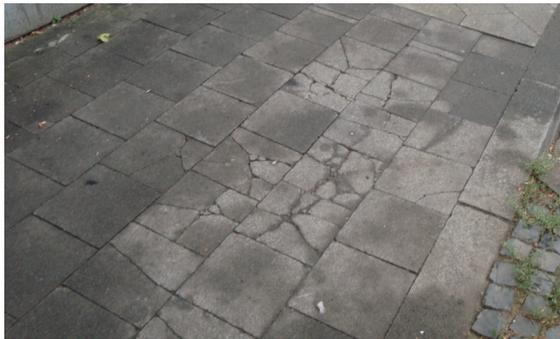
Abb. 7.5.1-3 Frostschaden im Bereich von Gehwegen (Quelle: Rupp)
