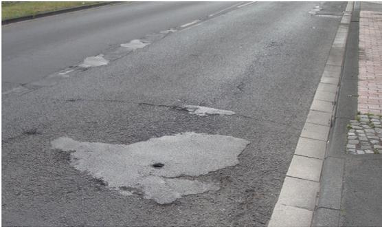
Abb. 7.5.1-1 Frostschaden im Bereich der Fahrbahn (Quelle: Rupp)
