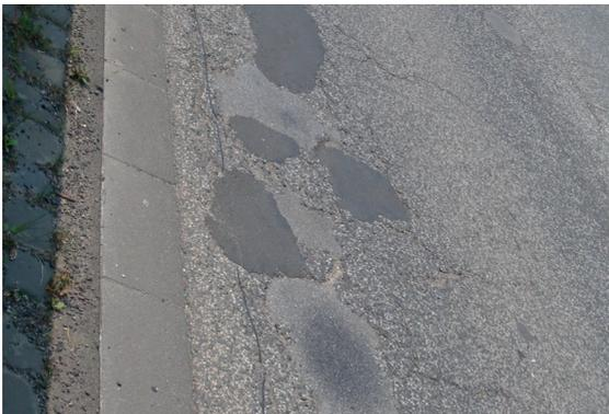
Abb. 7.5.1-2 Verschlussene Schlaglöcher im Bereich der Fahrbahn (Quelle: Rupp)
