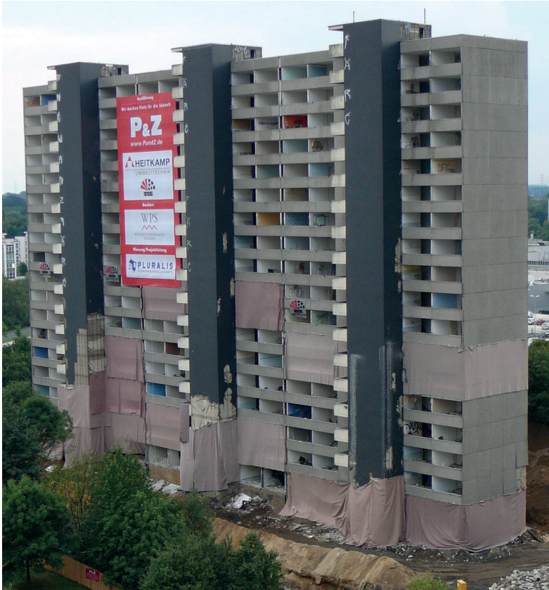
Abb. 4.3.4-2 Mit Vlies abgehängte Sprengeneben (Hochhaus Marl) (Quelle: W. Werner)
