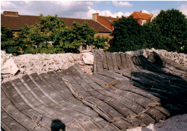
Abb. 4.3.4-3 Sprengschuttmatten aus Lkw-Reifen (Bunker Münster) (Quelle: W. Werner)
