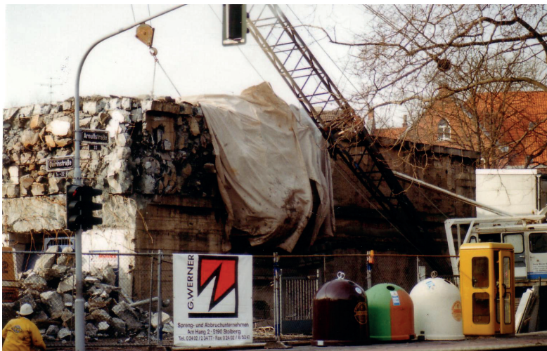
Abb. 4.3.4-4 Schutzwirkung bei Bunkersprengung in Düsseldorf-Oberkassel (Quelle: W. Werner)
