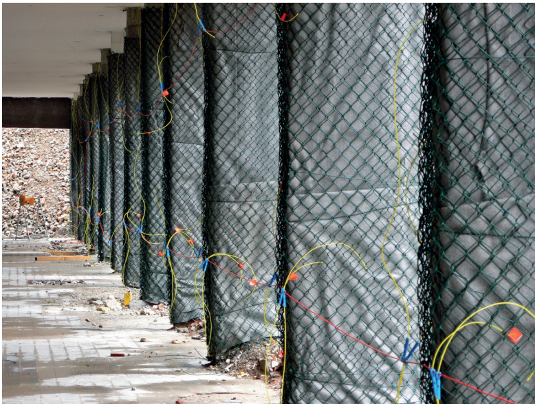
Abb. 4.3.4-1 Mit Geotextil und Maschendraht ummantelte Pfeiler (Krankenhaus Vöcklabruck) (Quelle: W. Werner)
