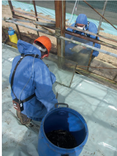
Abb. 5.4.4-1 Personenbezogene Messungen sichern bei diesen Arbeiten an festgebundenem Fensterkitt die Einhaltung der Konzentrationswerte (Quelle: D. Voss)
