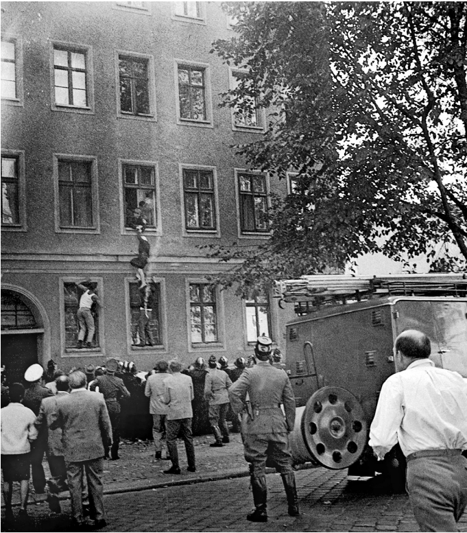
2 Fluchtversuch aus einem an der Sektorengrenze stehenden Haus, September 1961. Eine Frau versucht ein auf West-Berliner Seite bereit gehaltenes Sprungtuch zu erreichen. Von oben wird sie festgehalten, von unten wird versucht, sie an den Beinen herunterzuziehen. Am Ende gelingt die Flucht.
