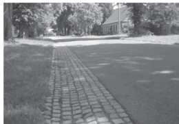
„Weiche Separation“ zwischen Fahrbahn und Seitenraum
