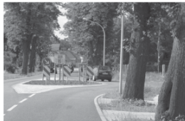
Geschwindigkeitsdämpfung im Ortseinfahrtbereich durch Mittelinsel mit deutlichem Fahrbahnversatz
