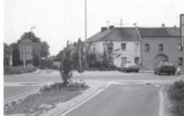
Geschwindigkeitsdämpfung im Ortseinfahrtbereich durch Kreisverkehr
