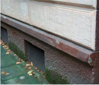
**Abb. 6.18:** Spritzwasser gegen die Fassade führte zu sichtbarem Algenbefall außen und einer Wanddurchfeuchtung.
