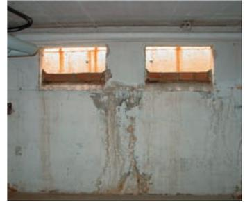
**Abb. 6.17:** Im Bereich der Kellerfenster bzw. in den Lichtschächten sammelt sich nach Regenfällen Wasser, das nicht abfließen kann, da die Entwässerung der Schächte nicht funktioniert. Das Wasser drückt gegen die Wand und dringt durch eine Stelle in das Gebäude.
