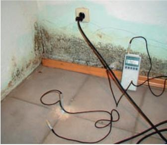
**Abb. 6.15:** Regenwasser lief über die Treppe in Richtung Eingangstür einer Souterrainwohnung und unter dem Türrahmen in den Fußboden. Es kam in allen Räumen zu Schimmelpilzbefall im Fußboden und auf allen Wänden nahe dem Fußboden.
