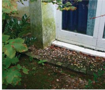
**Abb. 6.19:** Spritzwasser führte zu Algenbildung und Feuchtigkeit in der Wand im unteren Bereich der Türleibung.
