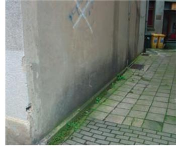
**Abb. 6.20:** Sichtbare Auswirkungen von Spritzwasser auf der Wand
