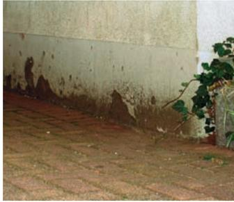
**Abb. 6.16:** Die Fläche vor dem Gebäude ist versiegelt und neigt sich in Richtung Gebäude. Niederschlagswasser wird nicht vom Gebäude ab-, sondern zu diesem hingeführt.
