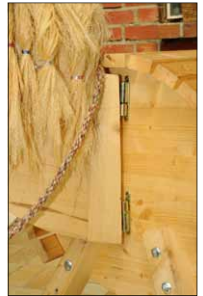
Durch die Scharniere lässt sich der Pferdekopf leicht nach links und rechts bewegen.
