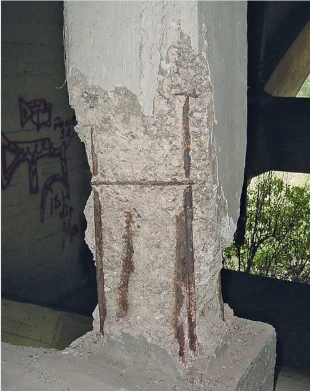
Abb. 1.142: Im Bewehrungsstoß fehlt die Bügelbewehrung vollständig. (Quelle: Straßen.NRW)
