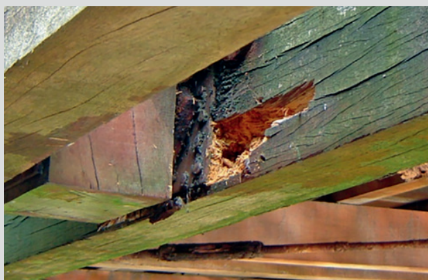
Abb. 1.111: Teilweise geöffnete, durch den Pilzbefall zerstörte Unterfurt (Quelle: Dr. Mertens Ingenieurgesellschaft mbH, Kevelaer)
