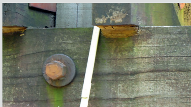
Abb. 1.110: Fruchtkörper des Ausgebreiteten Hausporlings (sog. Eichenporling) unter einem vorspringenden Querträger (Quelle: Dr. Mertens Ingenieurgesellschaft mbH, Kevelaer)
