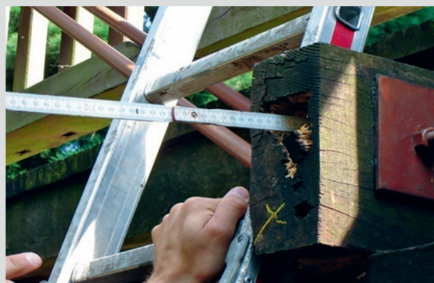
Abb. 1.112: Durch den Pilzbefall zerstörter Querträger. Nach Wegschlagen einer ca. 1 cm dicken Hirnholzschicht konnte der Zollstock ohne größeren Widerstand etwa 50 cm tief in den Querträger eingeschoben werden. (Quelle: Dr. Mertens Ingenieurgesellschaft mbH, Kevelaer)
