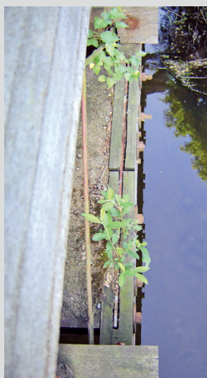
Abb. 1.109: Bewuchs eines Längsträgerstoßes; Unterhaltungsmangel, fehlender konstruktiver Holzschutz (Quelle: Dr. Mertens Ingenieurgesellschaft mbH, Kevelaer)
