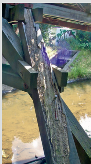
Abb. 1.108: Durch Fäulnis zerstörtes Stützenjoch (Quelle: Dr. Mertens Ingenieurgesellschaft mbH, Kevelaer)
