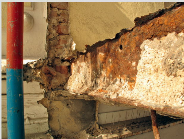
Abb. 2.76: Freigelegter Kragträger des Balkons mit massiven Korrosionsschäden
