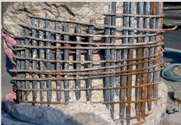
Abb. 1.152: Nicht vollflächig betonierte Bereiche eines Pfeilerfußquerschnittes (Quelle: Straßen.NRW)
