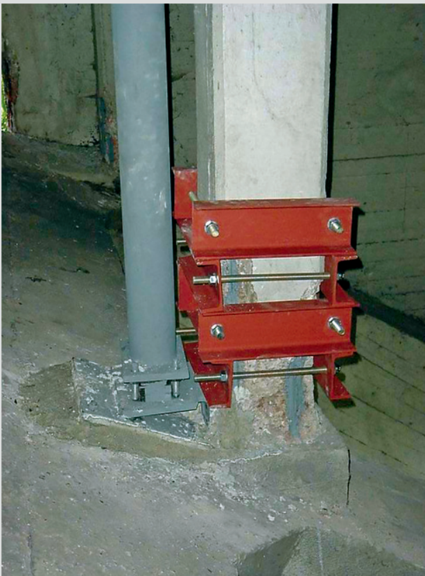
Abb. 1.143: Vorübergehende Instandsetzung als Sofortmaßnahme (Quelle: Straßen.NRW)
