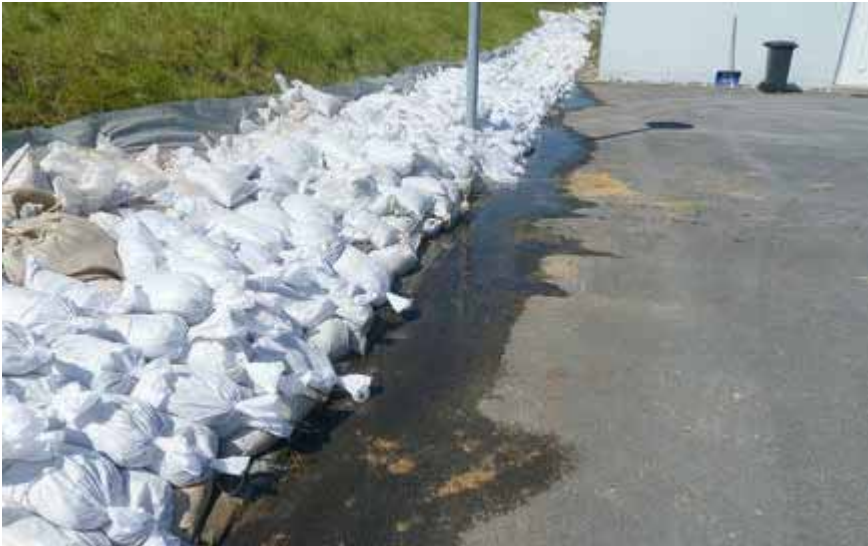
Abbildung 11: Landseitiger Schutz mit Vlies (Quelle: Baumann)
