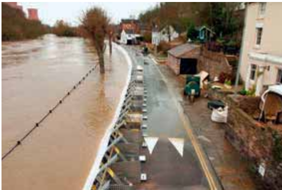
Abbildung 14: Mobiler Hochwasserschutzdamm (Quelle: IBB Hochwasserschutzsysteme Dresden)
