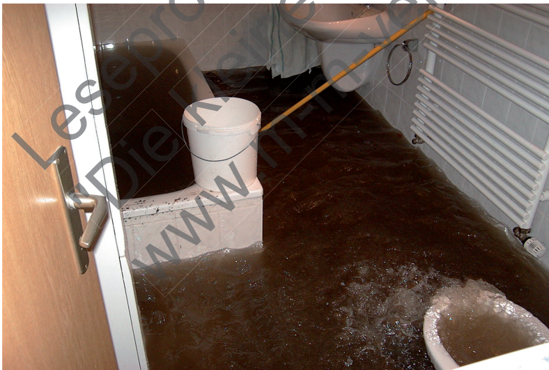
Abbildung 37: Überschwemmungsschaden infolge eines Rückstaus; Wasser fließt aus dem öffentlichen Kanalnetz bei einem Rückstauereignis in das Gebäude zurück und tritt aus den Entwässerungsgegenständen aus. 30
