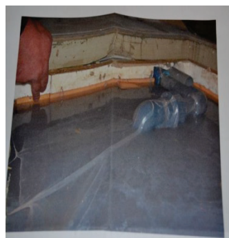
Abbildung 42: Der Pumpenschacht hat sich bis zur Dämmschicht der Fußbodenkonstruktion des schwimmenden Estrichs mit Schmutzwasser gefüllt, dieses ist in die Dämmschicht eingedrungen.
