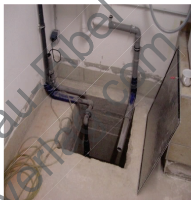
Abbildung 40: Schacht der Hebeanpumpe nach dem Entfernen der Fußbodenkonstruktion
