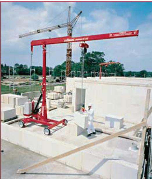
**Bild 2.3.13** Versetzgerät
