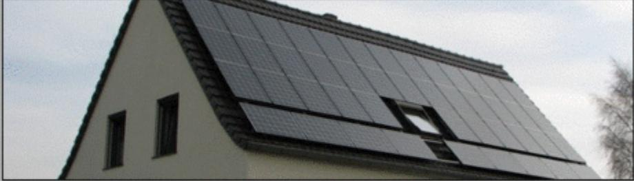
Mehrere Solarmodule aus Solarzellen, welche bei Lichteinfall Gleichspannung/Gleichstrom erzeugen, bilden eine PV-Anlage.
