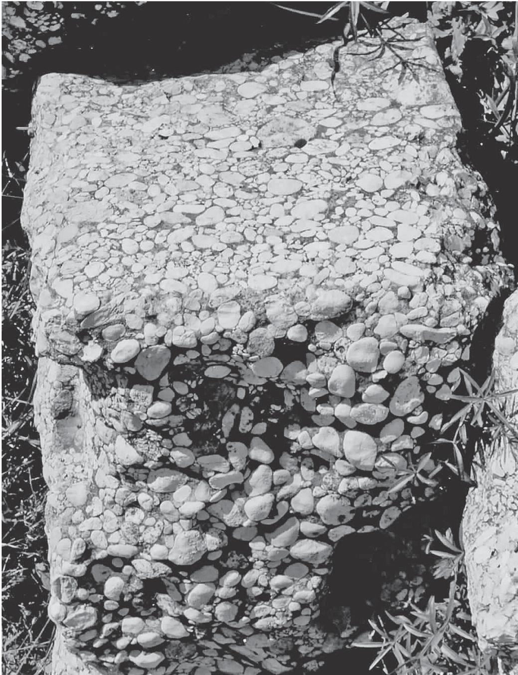
Abb. 2. Bei dem hier anstehenden, zum Straßenbau verwendeten Konglomeratgestein ist Bearbeitung (hier die obere Fläche) schwerer zu erkennen als beim charakteristischen Basaltpflaster der anderen römischen Konsularstraßen.
